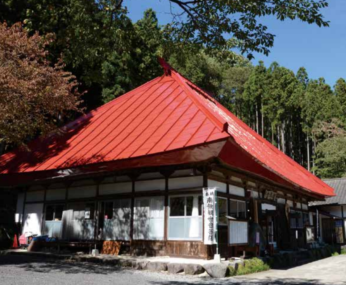
▲屋根が塗り直された本堂
