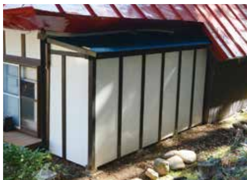
▲修繕後完成した倉庫
