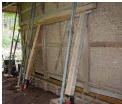
▲修繕中の本堂裏
