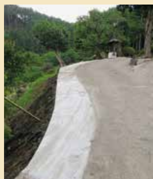
▲部分拡張された境内道路
