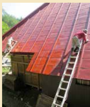
▲本堂屋根塗装風景
